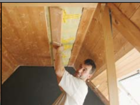
Die Täferstreifen werden wieder montiert.
