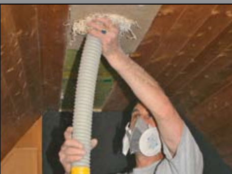
Die Hohlräume zwischen der bestehenden Dämmung und dem Unterdach werden vollständig mit isofloc befüllt.
